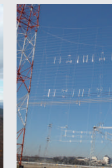
HF帯通信工事
